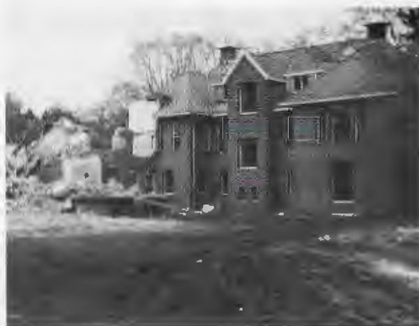
De kazerne-achtige "grote kant" valt onder de slopershamer.
